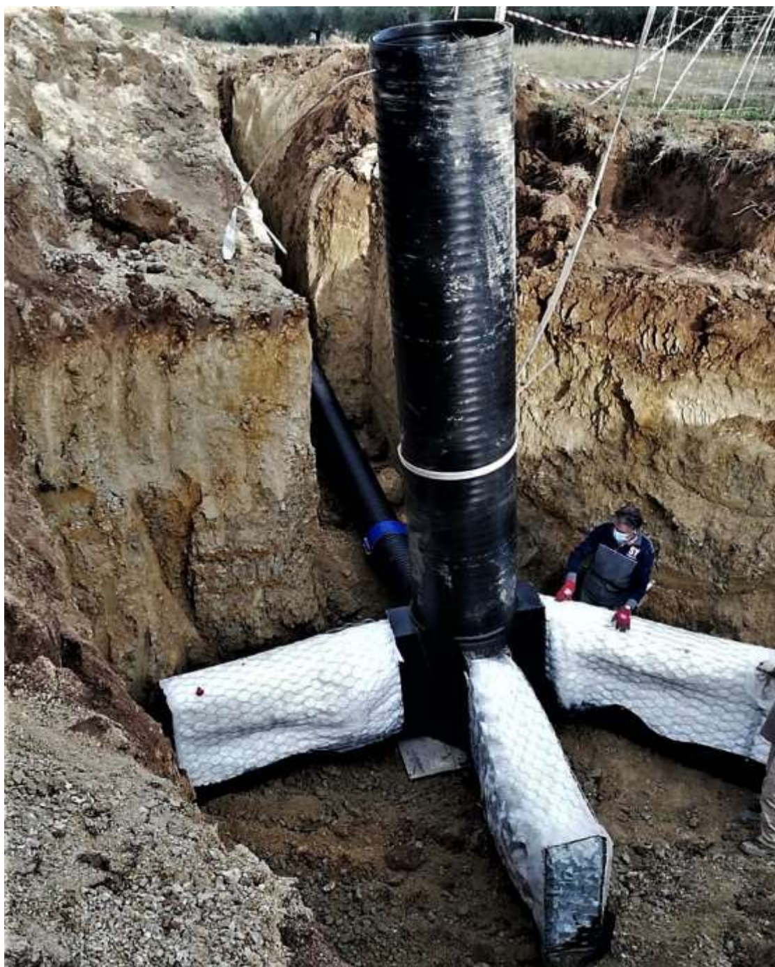
Realizzazione trincea drenante con pozzetti ispezione in PEAD – Tortoreto/ Cavatassi /TE Italia
